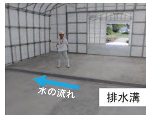
調製作業場内土間工
