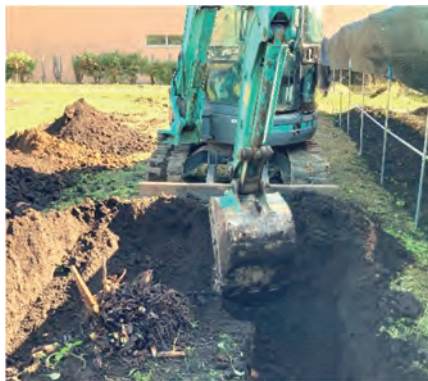
バックホーを用いた収穫作業
