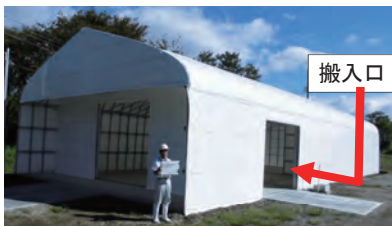
調製作業場外観
