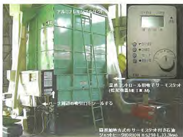
写真1 リレー式温度コントローラとジェットヒータによる上部加温送風方法
