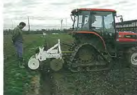
写真2 浅い弾丸暗渠の施工
