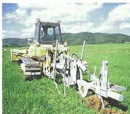
写真7 穿孔式無材暗渠施工
