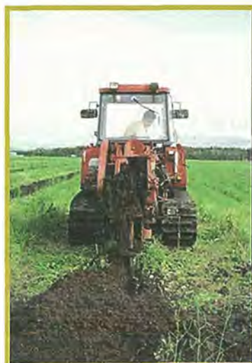
写真5 トレンチャー式 無材暗渠施工
