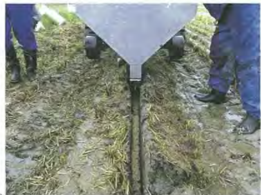
写真4 モミガラ再充填の様子
