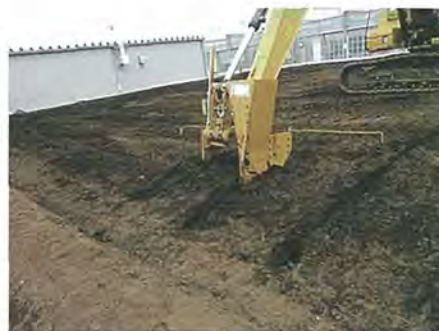
写真5 補助孔形成装置
