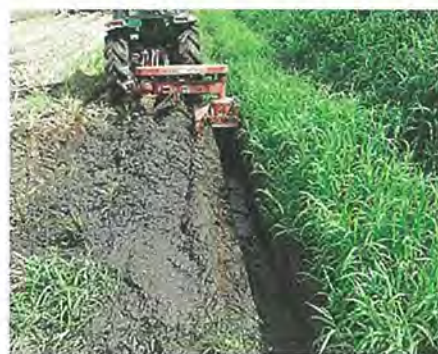
写真6 明渠による湧水処理
