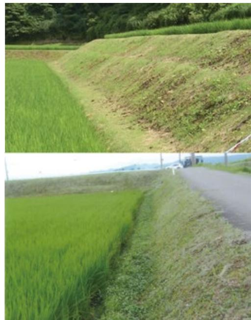
図 19 法面の途中に小段を設けた例 (上)
